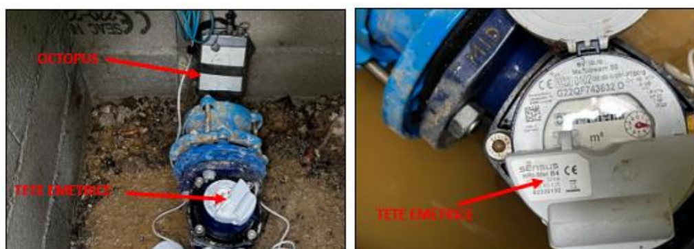
Photo 1 : Photographies du matériel de mesure pour débit sur compteur
